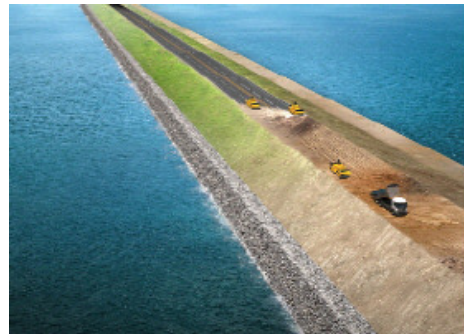
④ 도로포장 → 부대공사
